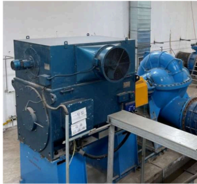
Gambar 2.1 Motor pompa pendingin sentrifugal
