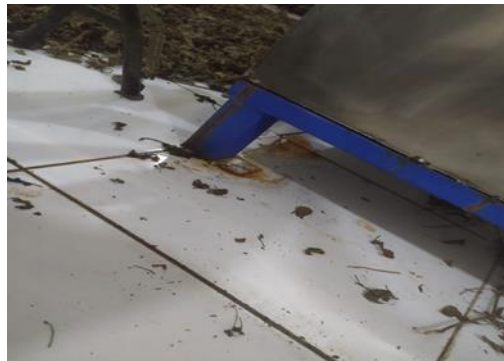
Gambar 1. 3 Failure pada Bak Air
