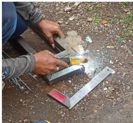
Gambar 4. 8 proses pengelasan menggunakan las busur
