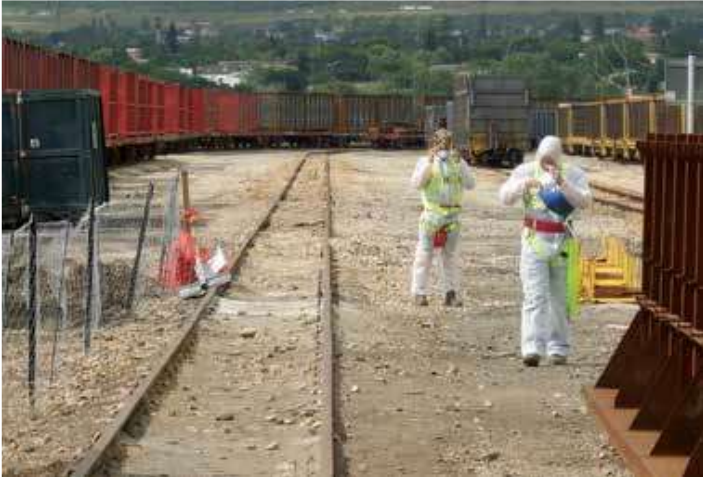
Gambar 3. Pakaian Pelindung Diri Pekerja pada Industri Konstruksi
