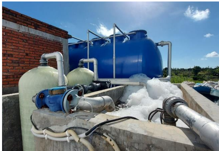
Gambar 5.7 Pabrik pengolahan air limbah
