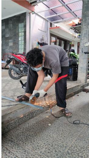
Gambar 4. 8. Proses Pemotongan dengan Gerinda Tangan
